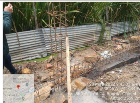
**Fotografía No. 7.** Actividad constructiva predio CHIP AAA0148KUNX, compactación del suelo, RCD, construcción vigas y soportes en cemento.
