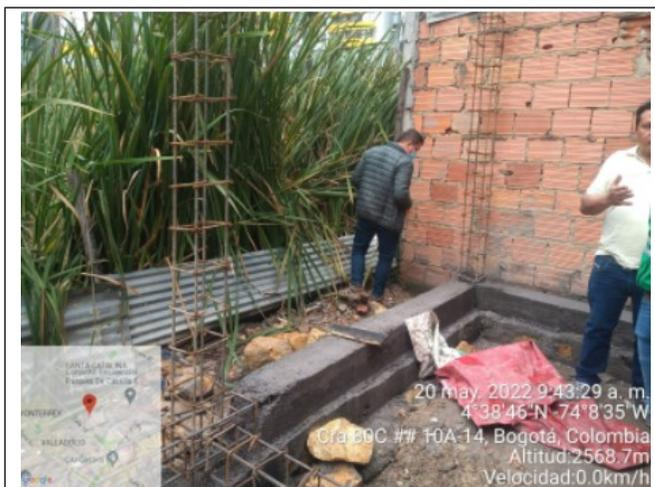
**Fotografía No. 5.** Actividad constructiva predio CHIP AAA0148KUNX, compactación del suelo, RCD, construcción vigas y soportes en cemento.
