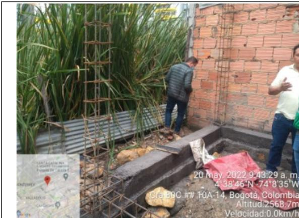
**Fotografía No. 6.** Actividad constructiva predio CHIP AAA0148KUNX, compactación del suelo, RCD, construcción vigas y soportes en cemento.
